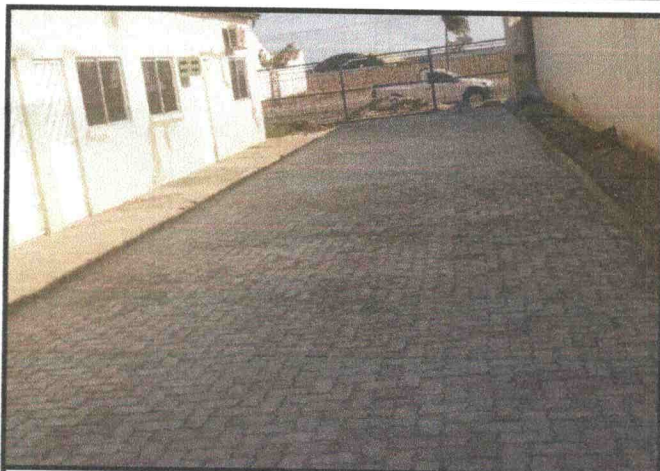
PAVIMENTAÇÃO EM INTERTRAVADO
