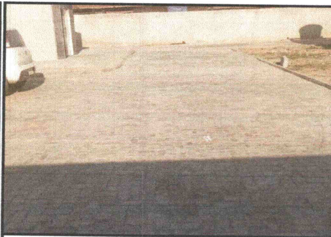
PAVIMENTAÇÃO EM INTERTRAVADO
