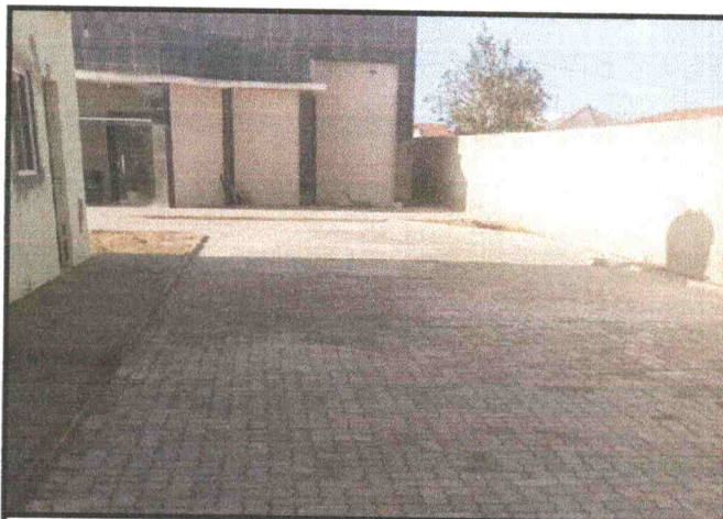
PAVIMENTAÇÃO EM INTERTRAVADO
