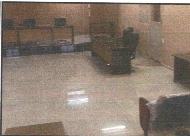
REVESTIMENTO DE PISO EM PORCELANATO
